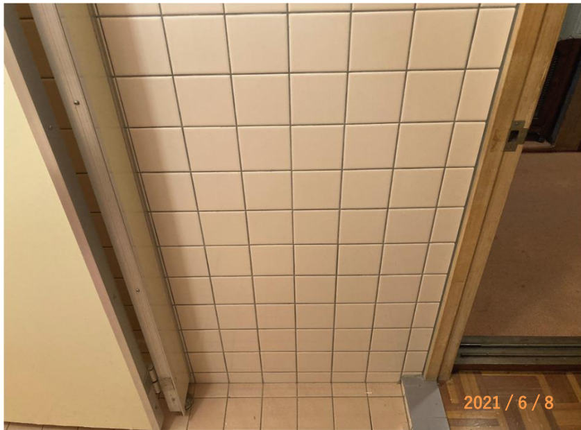
■現状写真■ (工事施工前)
